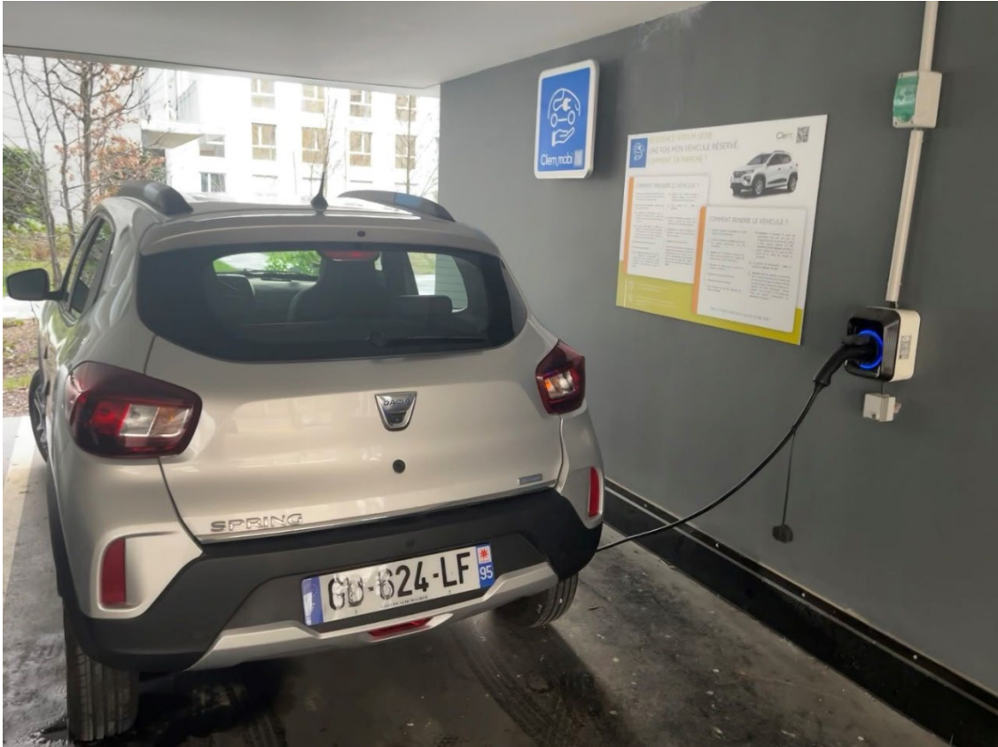
Exemple de station résidentielle à Clichy-sous-Bois (Cogedim)
